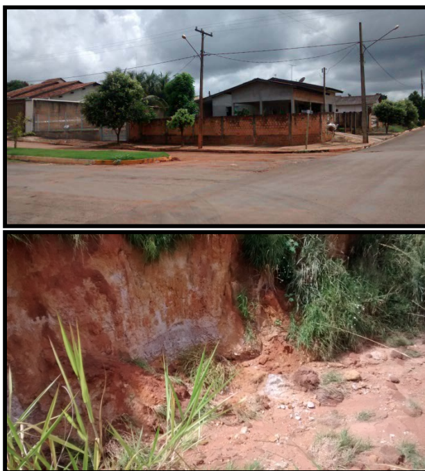
Foto 4 - Vista típica do trecho de jusante da subbacia com elevado assoreamento nas vias - Detalhe para erosões nas imediações da pequena "nascente" de corpo hídrico
