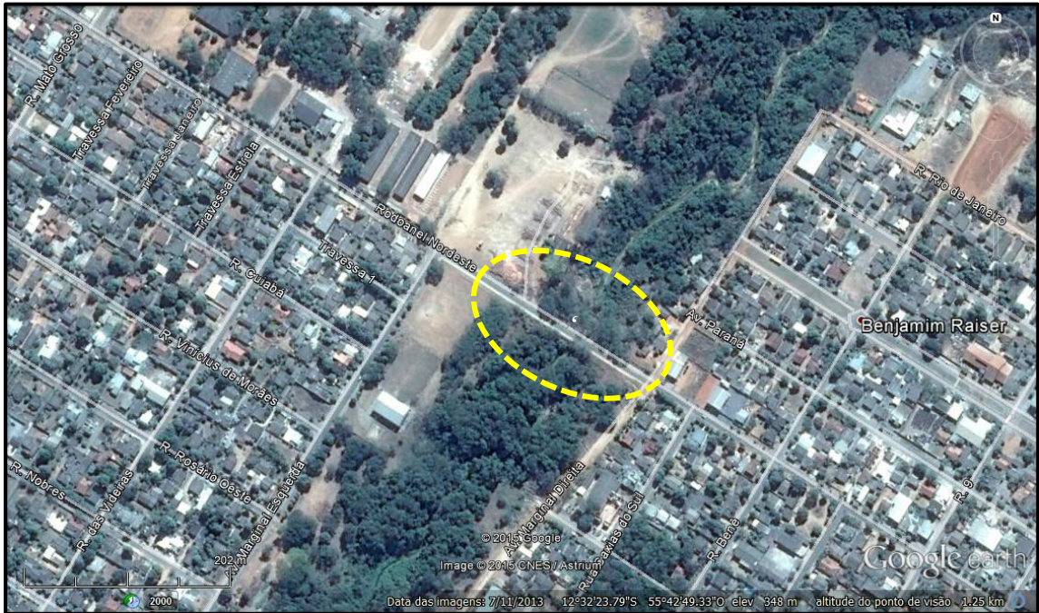
Imagem 4 - Localização de erosões na extremidade de jusante do Córrego Central (Fonte: Google Earth)
