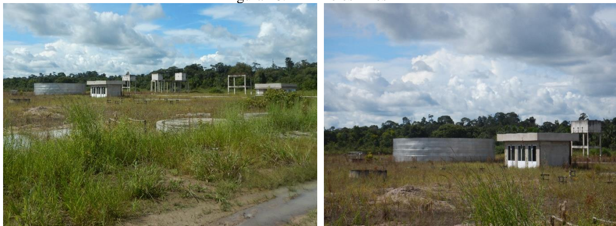
Figura 48. ETE Teles Pires
