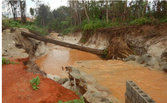
Figura 58. Erosão no rio pós-descarga
