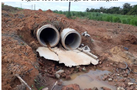
Figura 155. Descarga de drenagem
