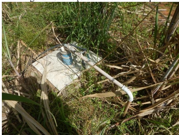
Figura 161. Poço da Escola Municipal
