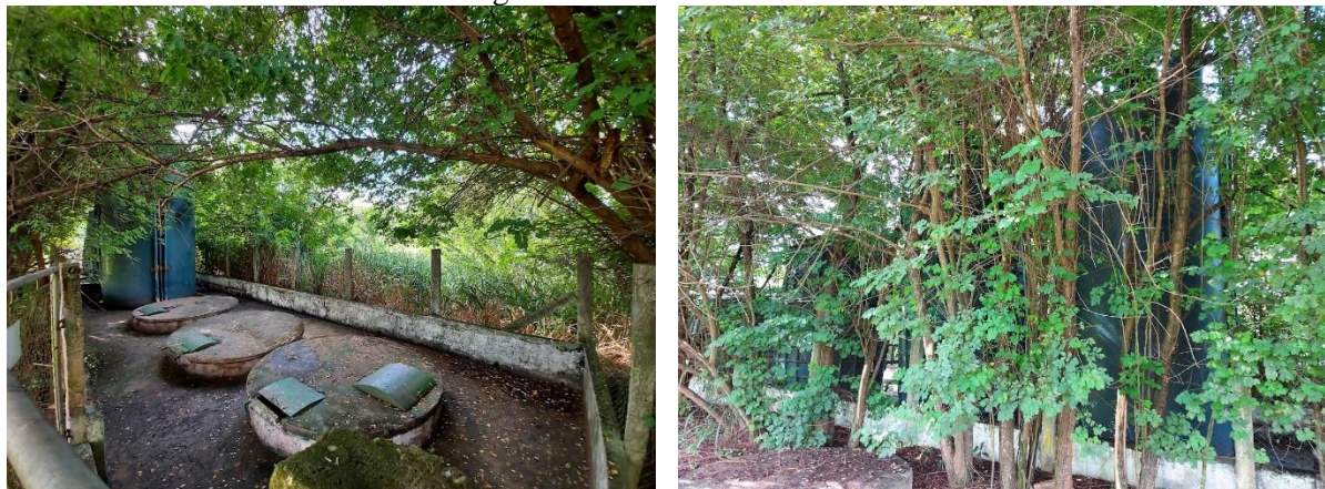
Figura 44. ETE São Francisco
