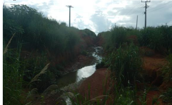
Figura 59. Trecho final do canal em terra MT-242
