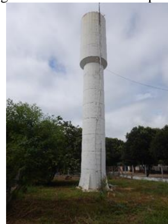
Figura 145. Reservatório tipo taça
