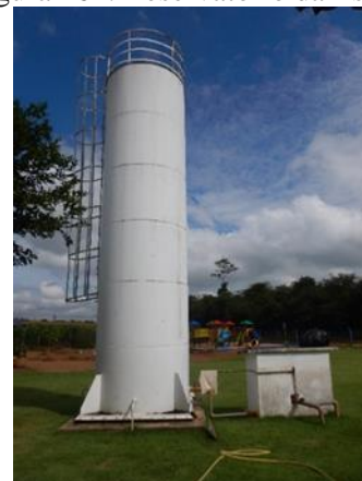
Figura 162. Reservatório da Escola
