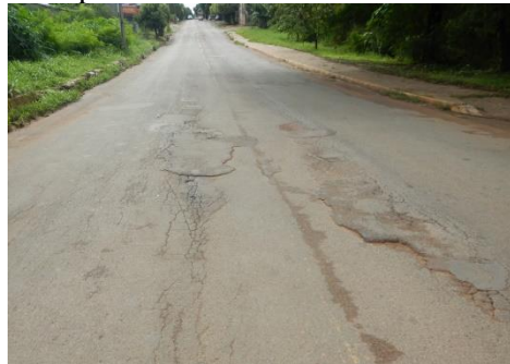
Figura xx: Fissuras no pavimento local do BCCA da Avenida Mário Raiter
