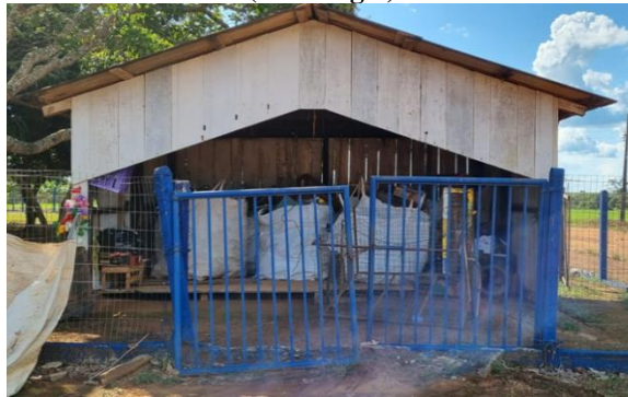
Figura 141. Acondicionador da Escola (Caravágio)
