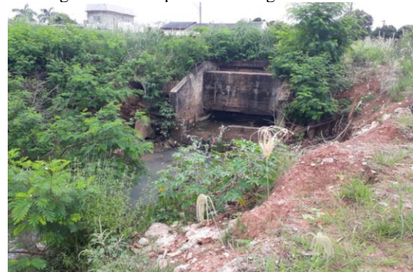
Figura 66. Dissipador de energia e entornos
