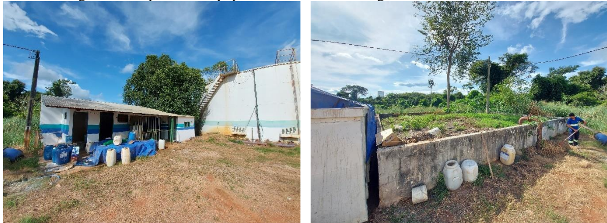
Figura 43. Depósito de equipamentos e leito de secagem de lodo – ETE Central
