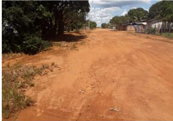
Figura 139. Sinais de erosão na Cinco
