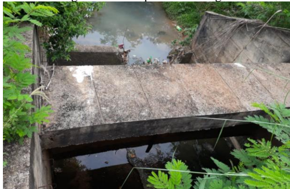
Figura 65. Dissipador de energia
