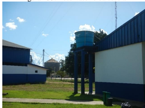
Figura 135. Reservatório da escola
