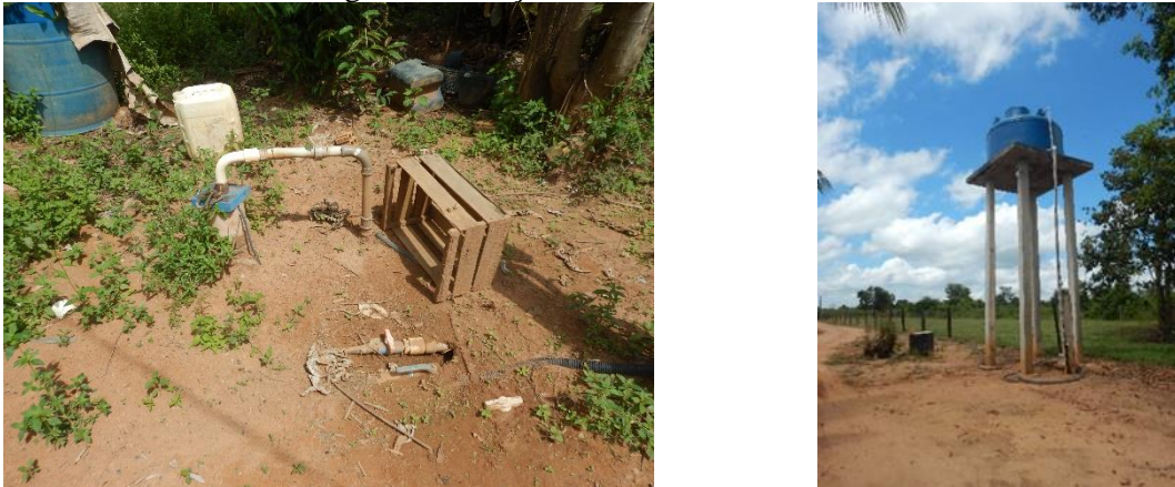
Figura 163. Poço e reservatório individual
