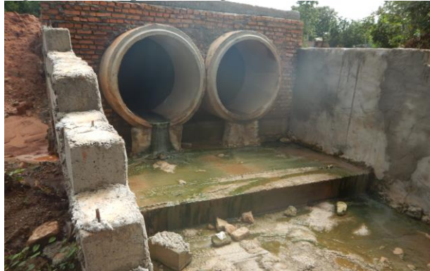
Figura 69. Dissipador energia Bairro São José
