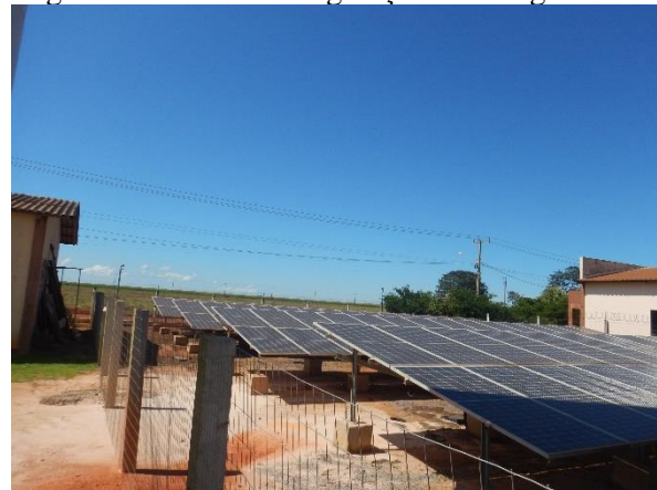
Figura 126. Sistema de geração de energia solar
