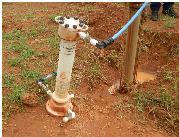
Figura 33. Detalhe do clorador
