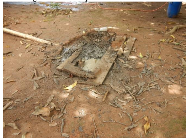
Figura 165. Lançamento à céu aberto
