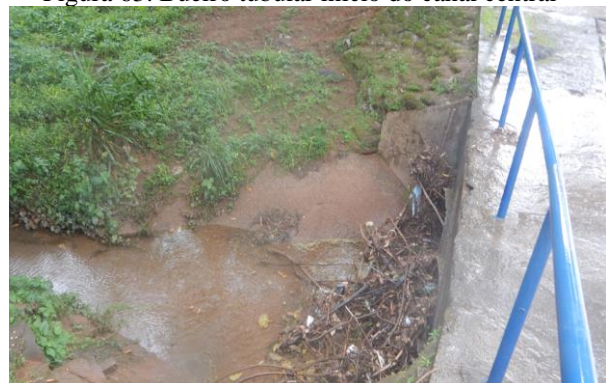
Figura 63. Bueiro tubular início do canal central
