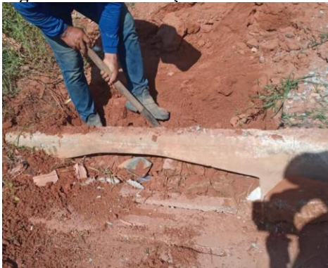
Figura 77. Desobstrução da boca de lobo
