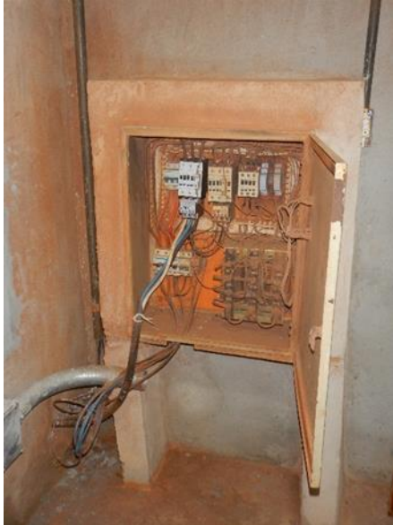
Figura 123. Painel de Controle (PT-01)
