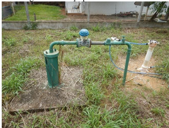
Figura 144. Poço profundo e clorador
