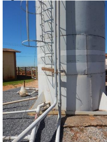
Figura 117. Detalhe do reservatório
