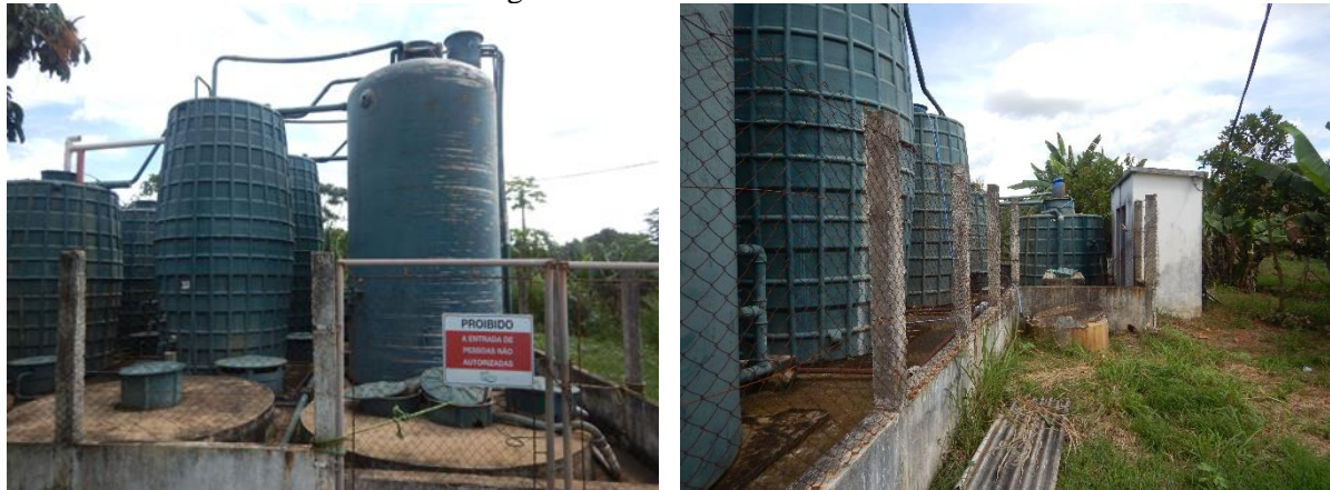
Figura 45. ETE Santa Maria
