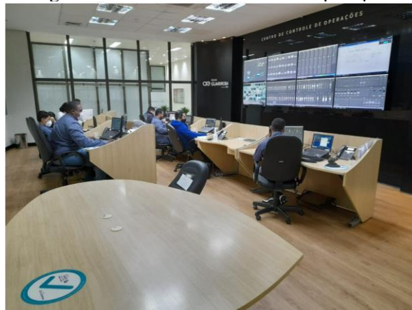
Figura 35. Centro de Controle de Operações
