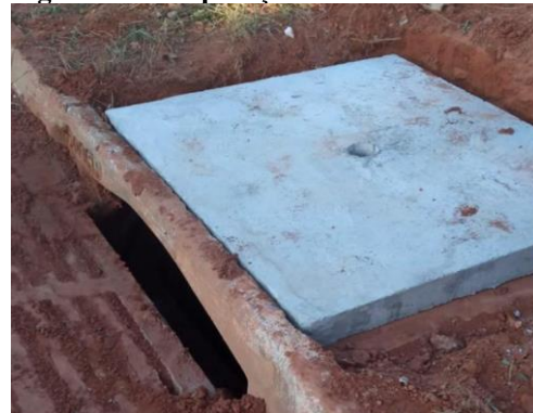
Figura 78. recuperação da boca de lobo
