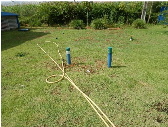
Figura 164. Fossa séptica da Unidade de Saúde
