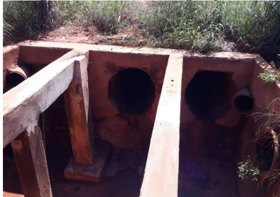
Figura 129. Caixa coletora águas pluviais
