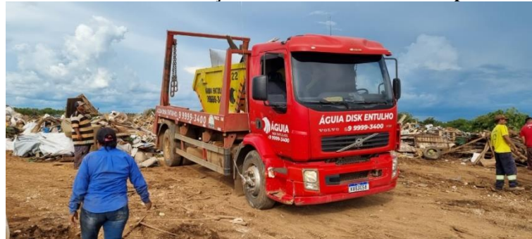
Figura 106. Resíduos da construção civil sendo recebido no Depósito Municipal
