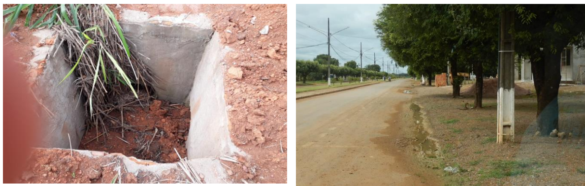
Figura 157. Dispositivos de captação com necessidade de manutenção
