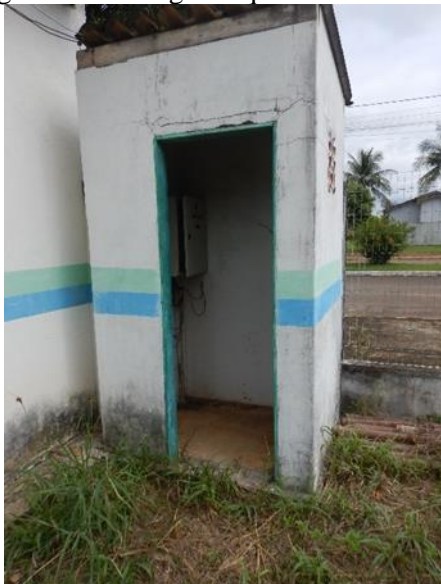
Figura 148. Abrigo do quadro de comando
