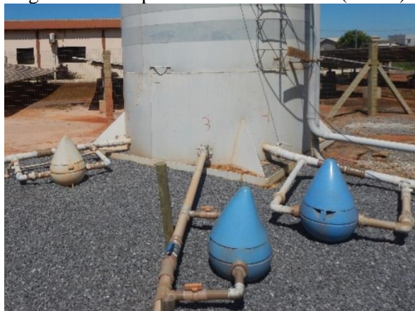
Figura 118. Dispositivos de tratamento (PT-01)
