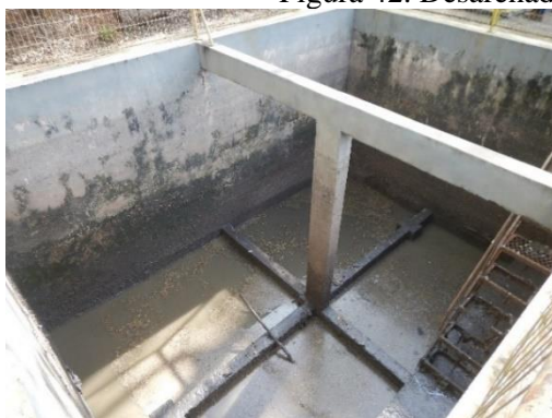
Figura 42. Desarenador e reator UASB – ETE Central
