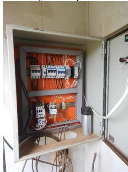
Figura 149. Quadro de comando
