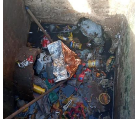
Figura 74. Boca lobo obstruída com RS
