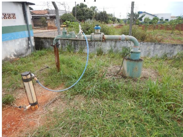
Figura 32. Dispositivo para cloração ligado ao poço
