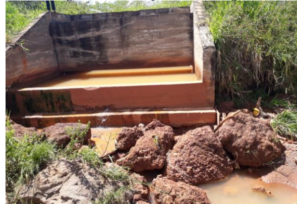
Figura 130. Dissipador de energia
