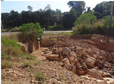
Figura 60. Erosão no bueiro canal terra MT-242
