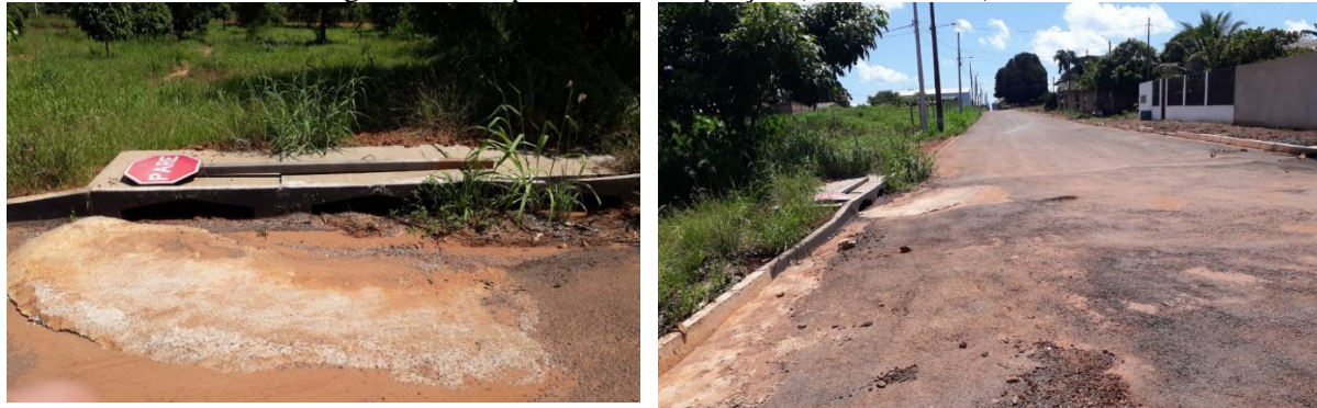
Figura 126. dispositivos de captação (bocas de lobo)
