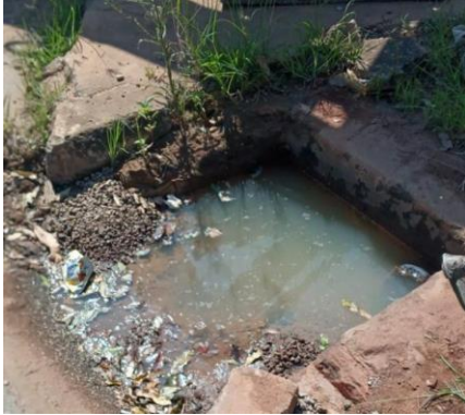
Figura 73. Boca lobo obstruída com esgoto e RS
