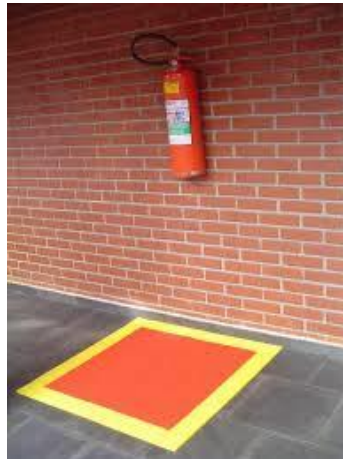
Figura 6 - Sinalização no Piso - Demarcação do Extintor
