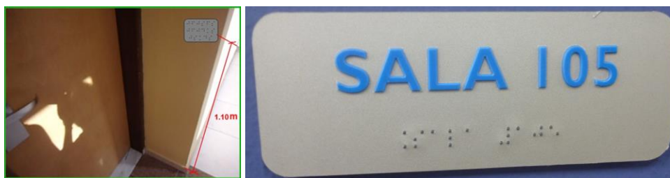
Figura 45 - Placa de Identificação de ambiente com identificação em braile. Fonte: Google
