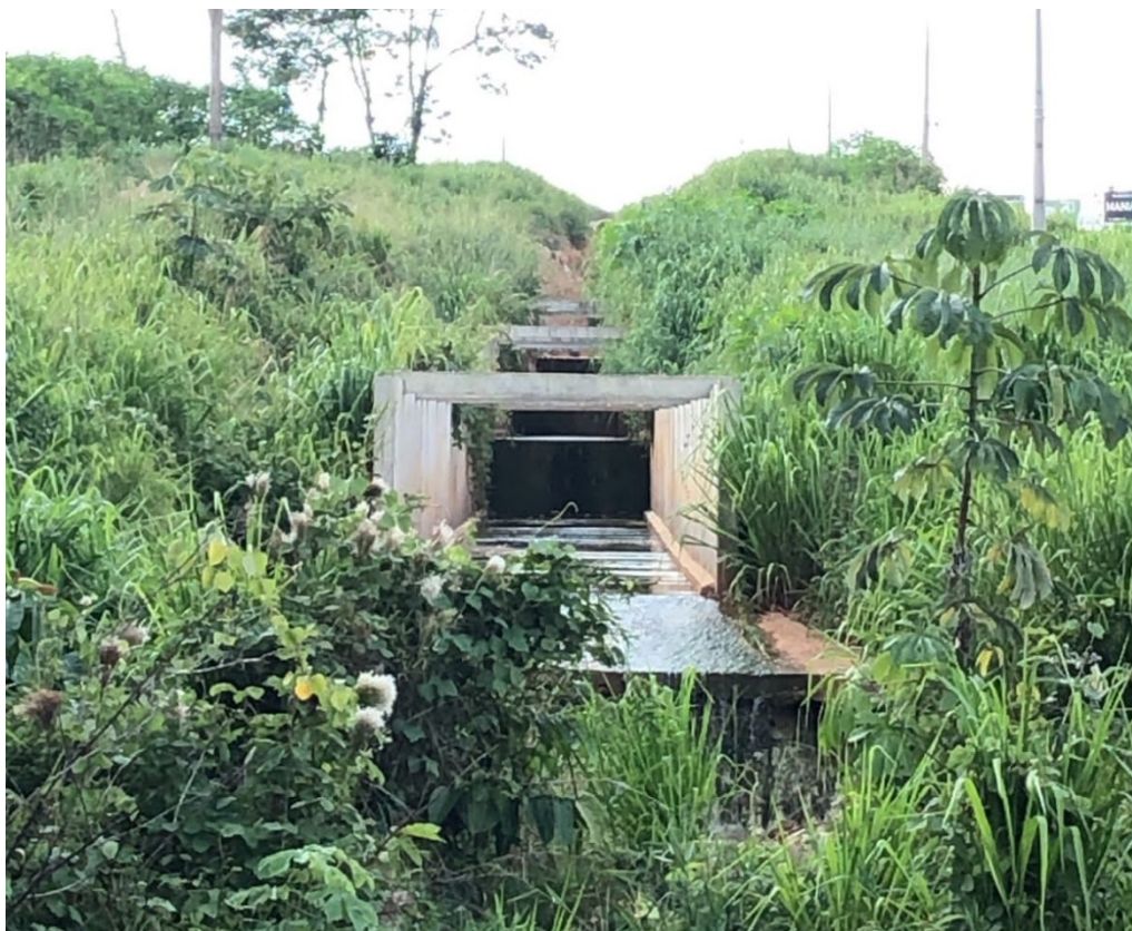
Vala MT-242 - canal de concreto construído
