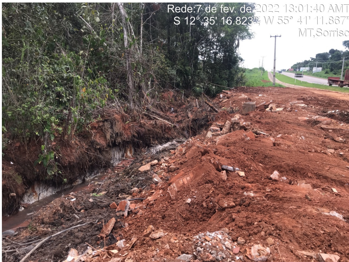
Vala MT-242 - vala de escoamento - intervenção próxima ao Rio Lira
