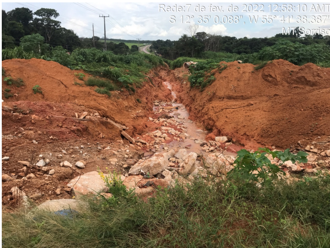
Vala MT-242 - vala de escoamento com processos de erosão
