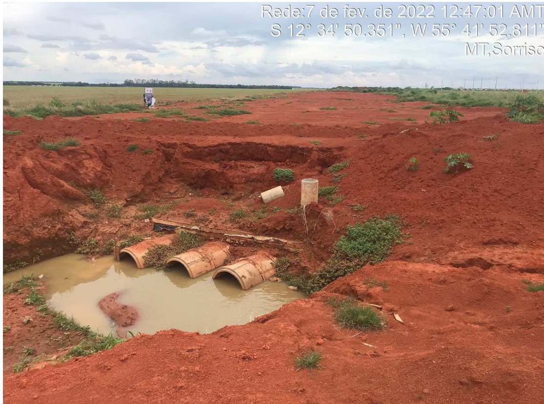
Vala MT-242 - tubulação da drenagem do Mário Raiter
