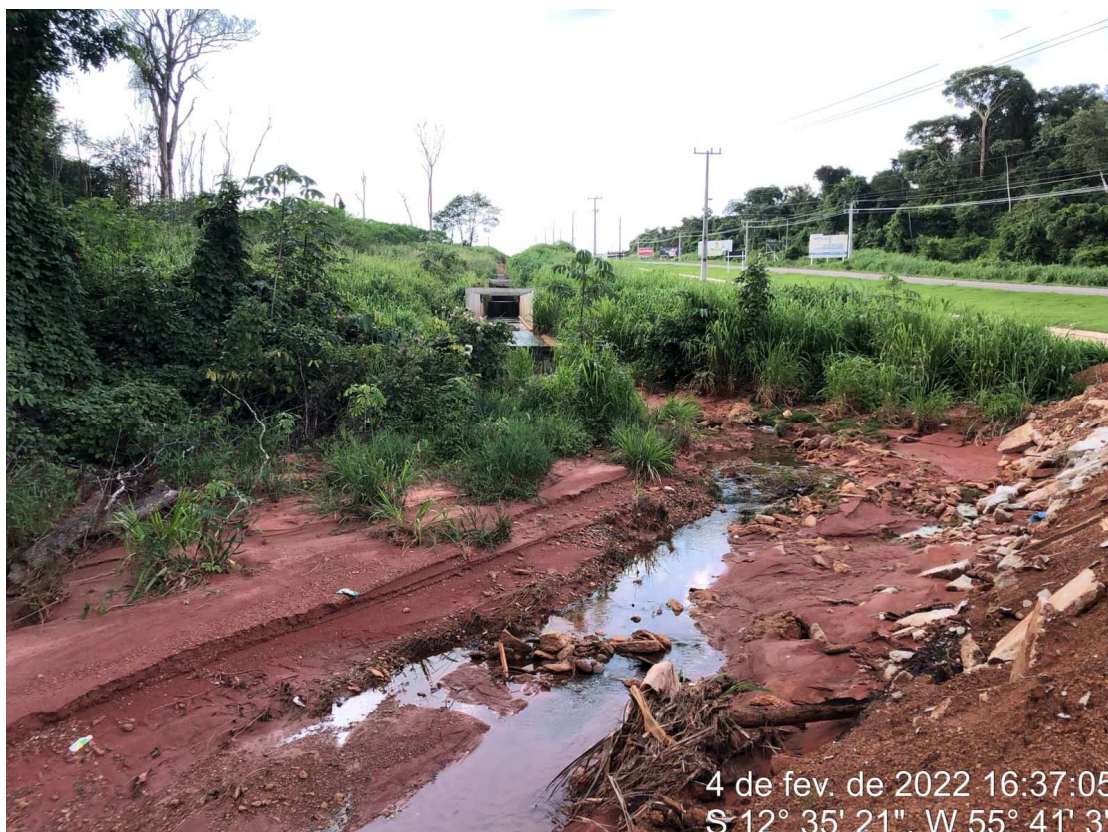
Vala MT-242 - canal de concreto construído
