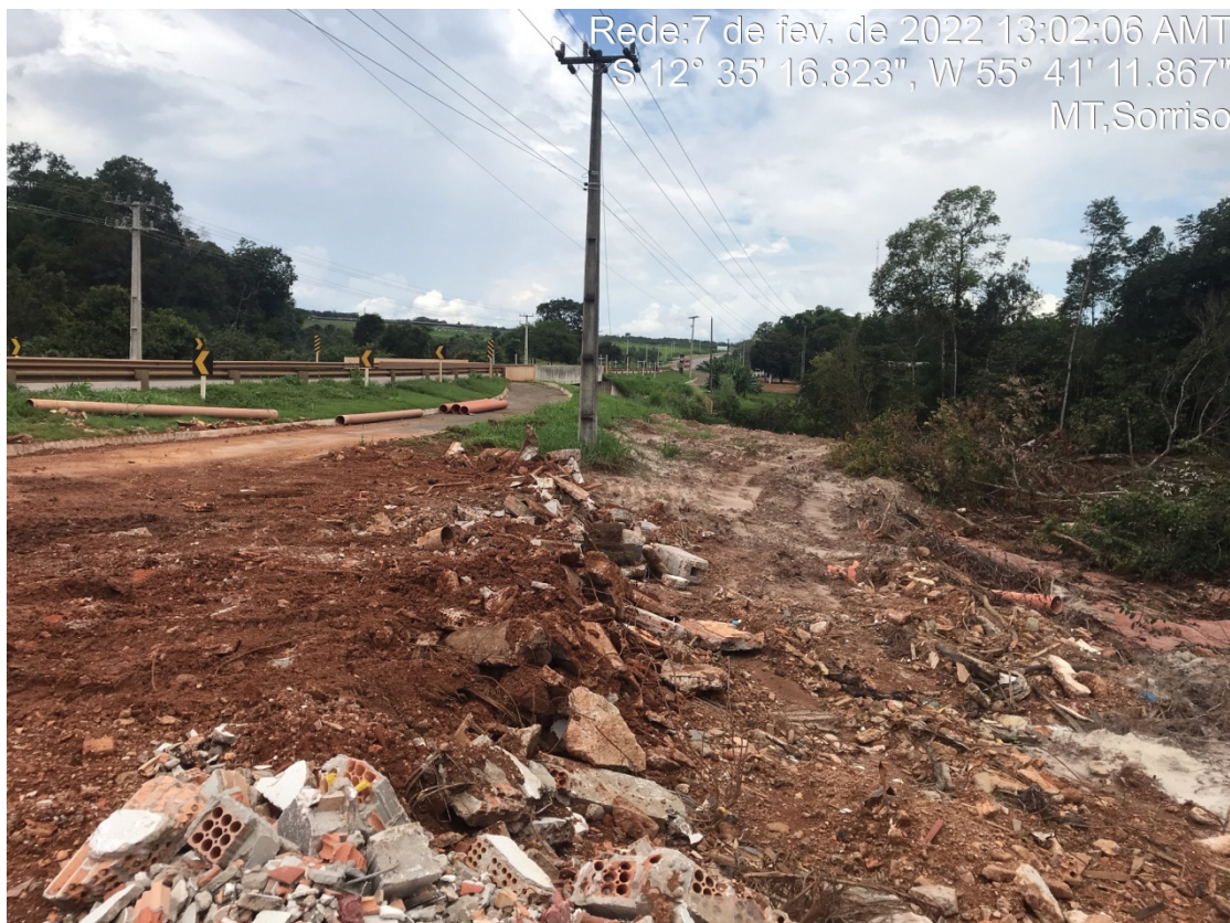
Vala MT-242 - vala de escoamento próxima ao Rio Lira
