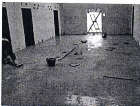
Aplicação do Korodur no Prédio Triagem
