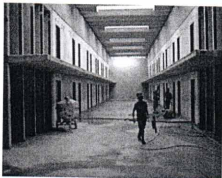
Aplicação do Korodur na galeria "B"
