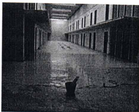
Aplicação do Korodur na galeria "A"
